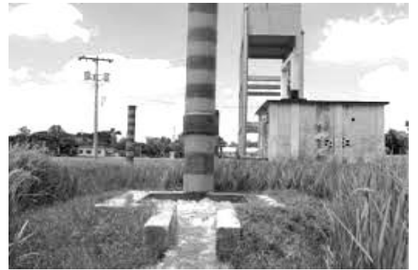
চিত্র ১.৫: বরেন্দ্র সেচ প্রকল্পের আওতায় পরিচালিত গভীর নলকূপ।
