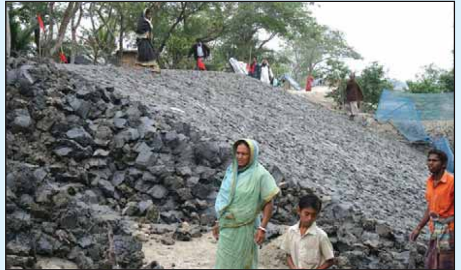
দুর্যোগ মোকাবেলার্থে গ্রাম রক্ষা বাঁধ নির্মাণ কার্যক্রম
