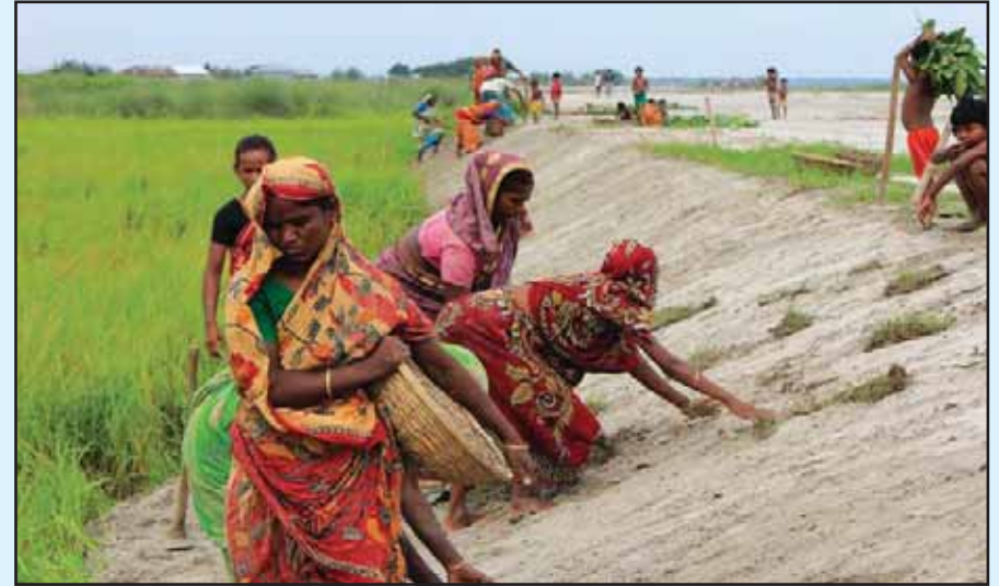
সকলের অংশগ্রহণে গ্রাম রক্ষার্থে সড়ক ও কিল্লা নির্মাণ কার্যক্রম
