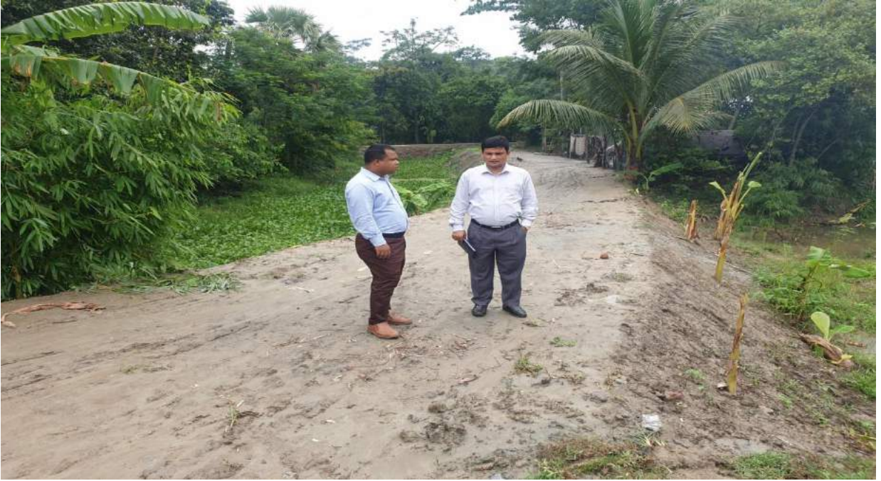
চিত্রঃ ১৭ জনাব মোঃআব্দুর রহমান ,জেলা ত্রাণ ও পুনর্বাসন কর্মকর্তা, গোপালগঞ্জ এবং উপজেলা প্রকল্প বাস্তবায়ন কর্মকর্তা, কোটালীপাড়া, গোপালগঞ্জ কর্তৃক কবি সুকান্তের বাড়ির সামনের ব্রীজ হতে রমেন মন্ডলের বাড়ী পর্যন্ত রাস্তা নির্মাণ কাজ পরিদর্শন।
