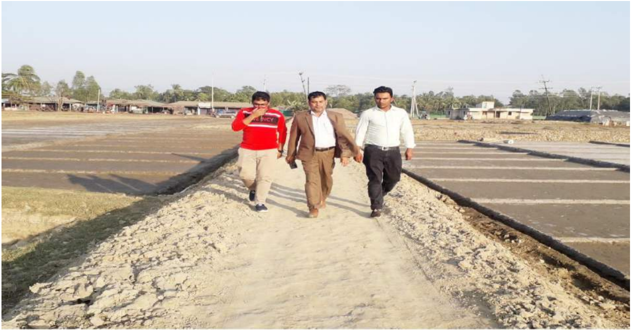
চিত্রঃ ০৬ জনাব মোঃ জাহাঙ্গীর আলম, জেলা ত্রাণ ও পুনর্বাসন কর্মকর্তা, কক্সবাজার কর্তৃক টেকনাফ সদর আনাস বিন মালেক (রাঃ) মাদ্রাসার ঈদগাহ মাঠ হতে পূর্ব গোদারা বিল মৃত হোছেন এর বাড়ির সামনে পর্যন্ত রাস্তার মাটি ভরাট প্রকল্প পরিদর্শন।
