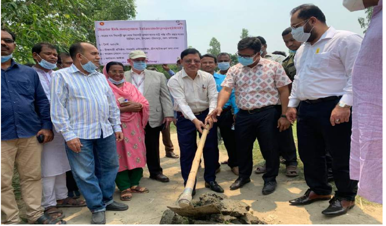
চিত্রঃ ০৩ জনাব সুব্রত পাল চৌধুরী, প্রকল্প-পরিচালক কর্তৃক মানিকগঞ্জ জেলার হরিরামপুর উপজেলার চালা ইউনিয়নের কাঁচা রাস্তা সংস্কার ও মেরামতের কাজ উদ্বোধন।
