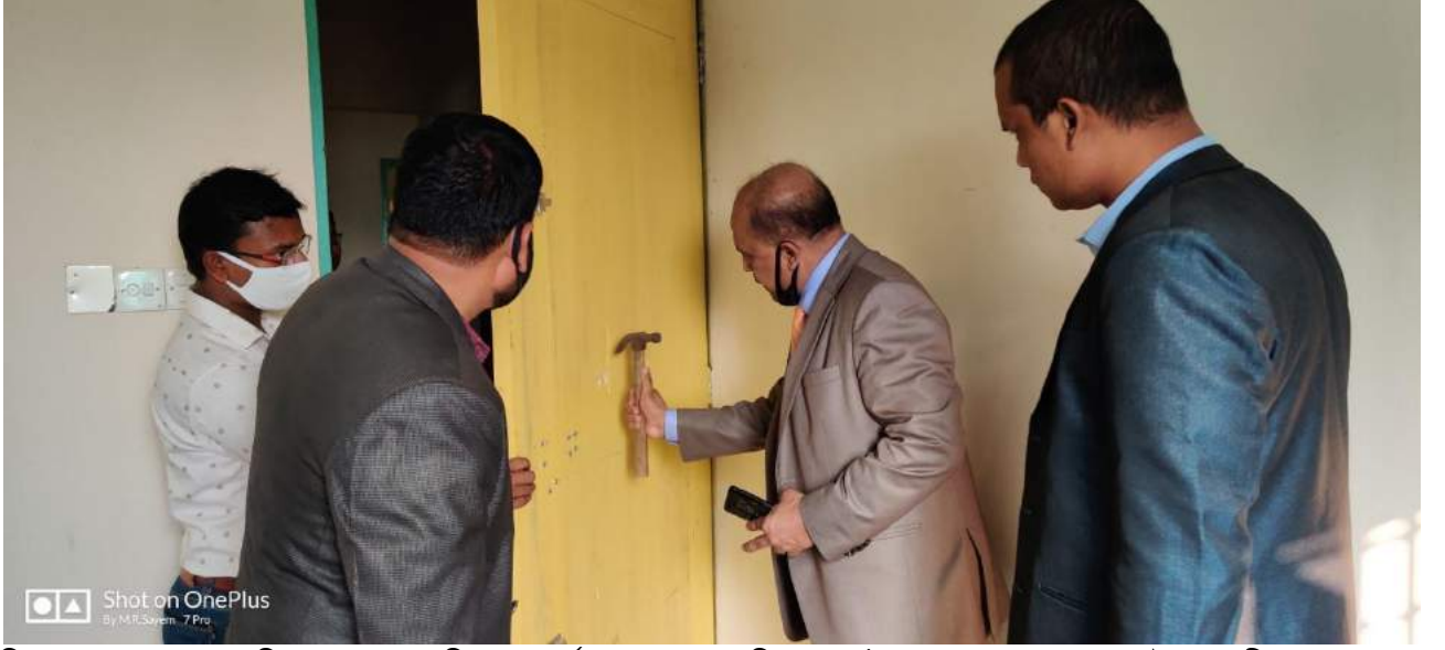
চিত্রঃ ০১ জনাব মোঃ আতিকুল হক, মহাপরিচালক, দুর্যোগ ব্যবস্থাপনা অধিদপ্তর কর্তৃক কক্সবাজার জেলার রামু উপজেলাধীন মনছুর আলী সিকদার আইডিয়াল স্কুল বহুমুখী ঘূর্ণিঝড় আশ্রয়কেন্দ্র নির্মাণ প্রকল্পস্থল সরেজমিন পরিদর্শন।
